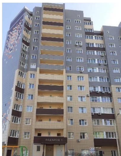
Фото. 3. Внешний вид жилого дома
