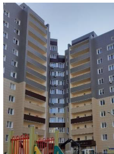
Фото. 4. Внешний вид жилого дома
