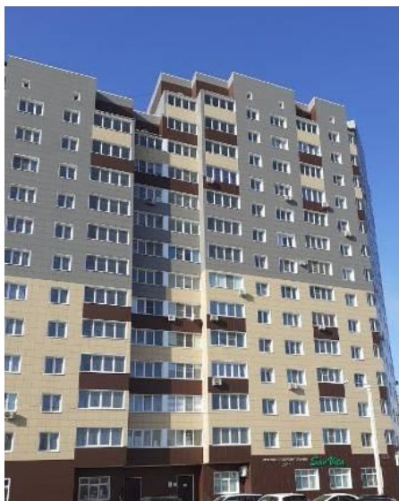
Фото. 1. Внешний вид жилого дома
