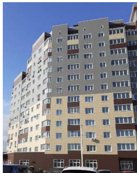
Фото. 2. Внешний вид жилого дома
