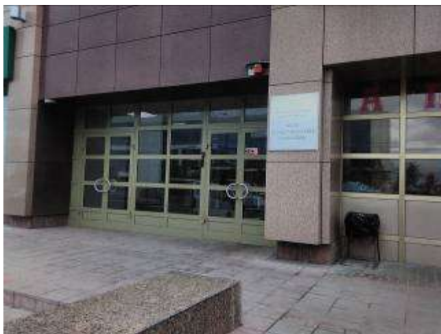
Фото 3. Вход в оцениваемое помещение
