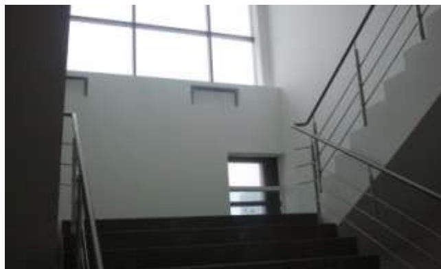
Фото 6. Лестницы оцениваемого помещения
