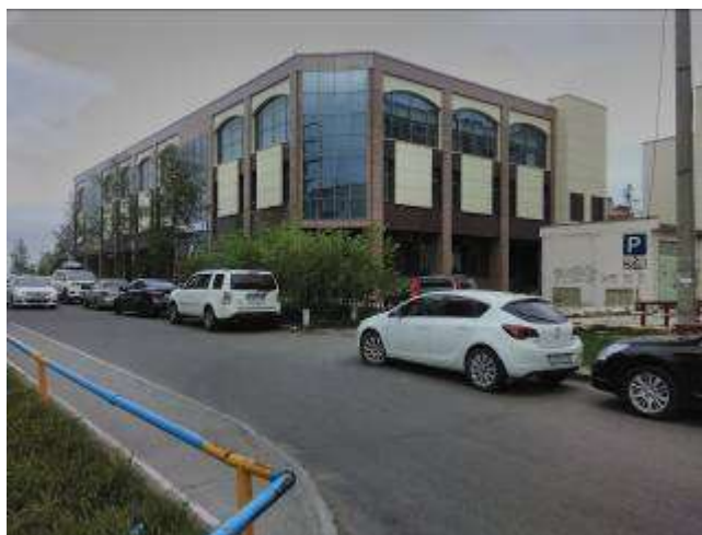
Фото 1. Внешний вид здания
