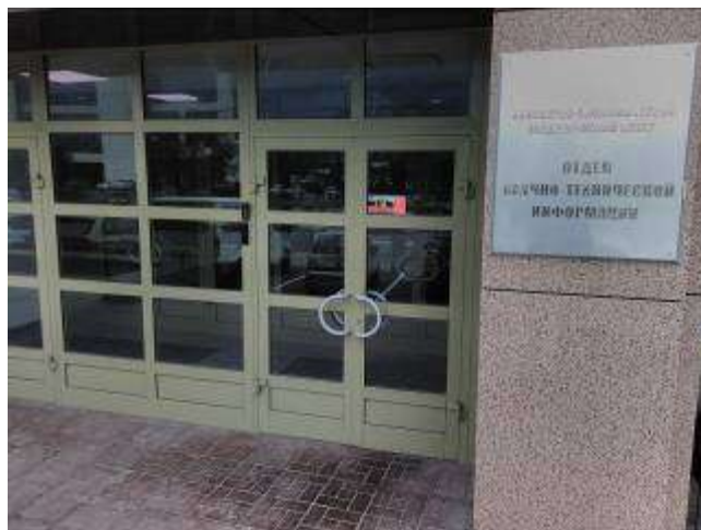
Фото 4. Вход в оцениваемое помещение
