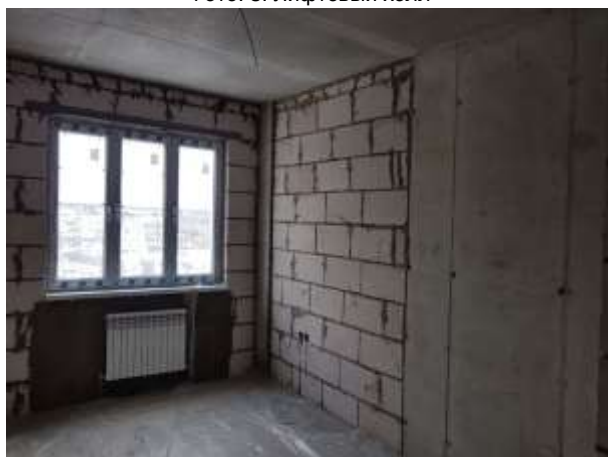
Фото 5. Вид внутри квартир
