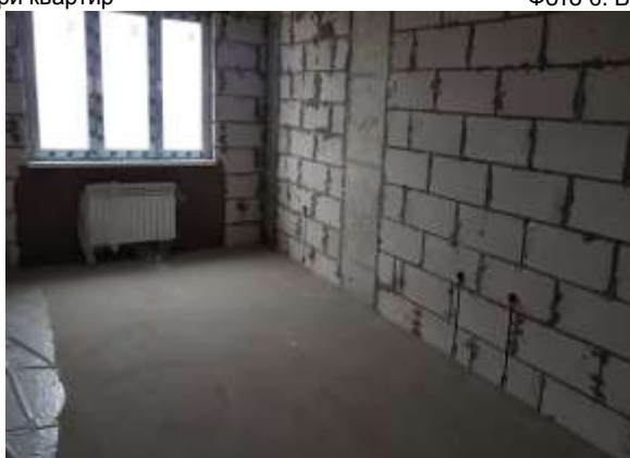
Фото 7. Вид внутри квартир
