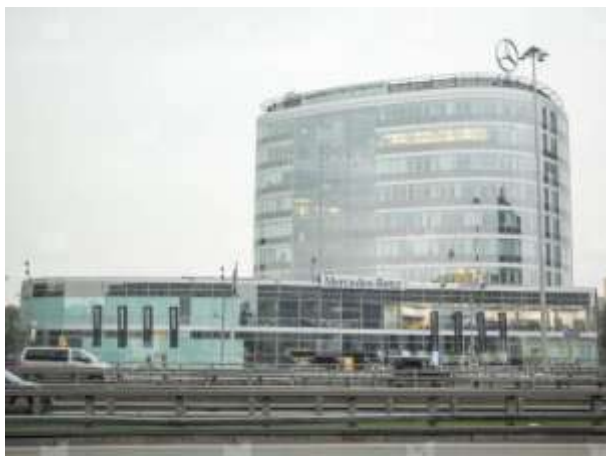
Фото 1. Внешний вид здания
