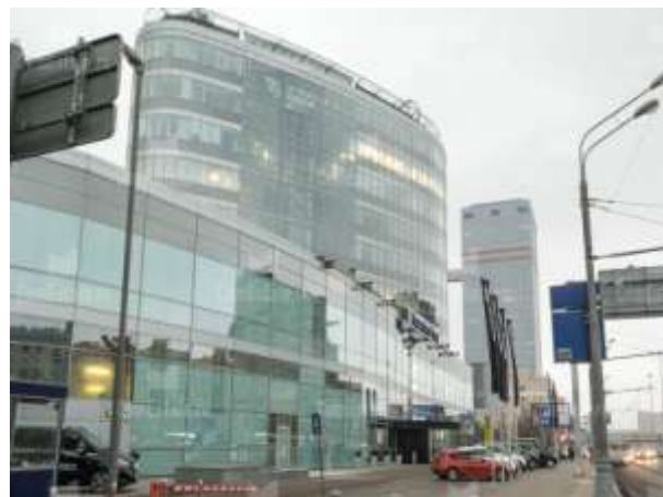
Фото 2. Внешний вид здания и окружающей застройки
