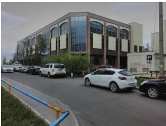
Фото 1. Внешний вид здания
