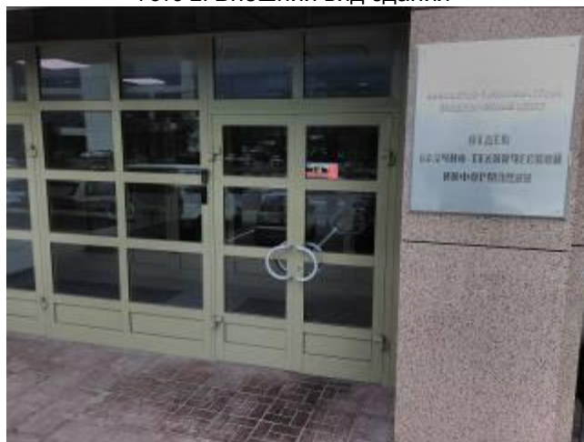
Фото 4. Вход в оцениваемое помещение
