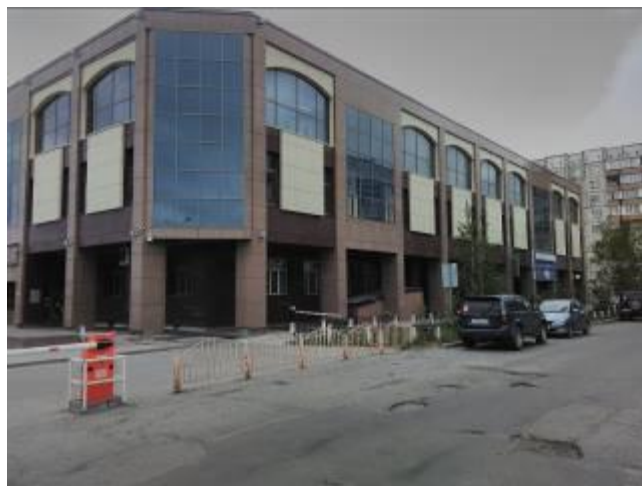
Фото 2. Внешний вид здания
