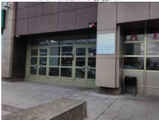
Фото 3. Вход в оцениваемое помещение
