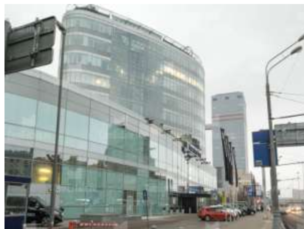
Фото 2. Внешний вид здания и окружающей застройки
