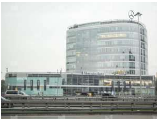
Фото 1. Внешний вид здания
