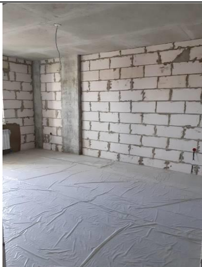
Фото 11. Внутренний вид жилых помещений
