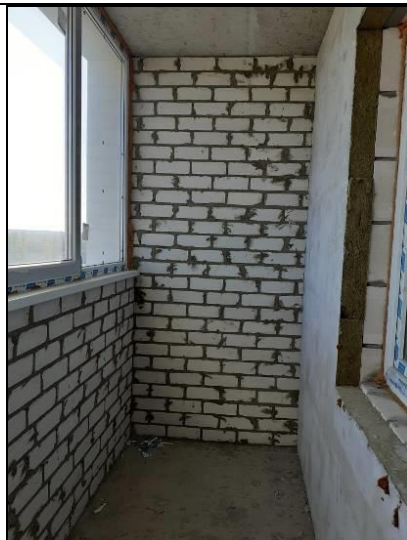
Фото 12. Внутренний вид жилых помещений
