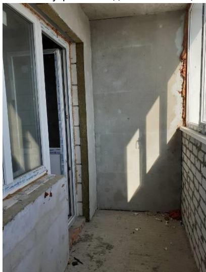
Фото 13. Внутренний вид жилых помещений
