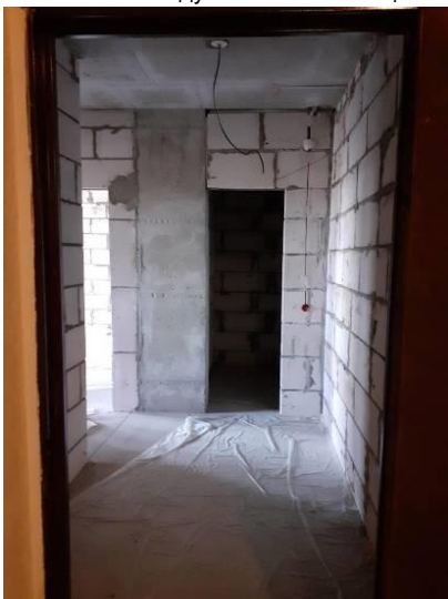
Фото 9. Внутренний вид жилых помещений
