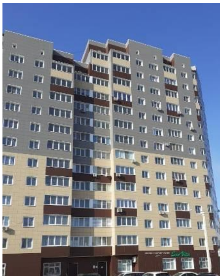
Фото. 1. Внешний вид жилого дома
