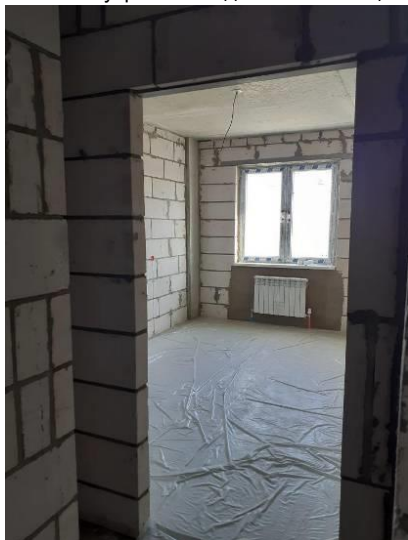
Фото 15. Внутренний вид жилых помещений
