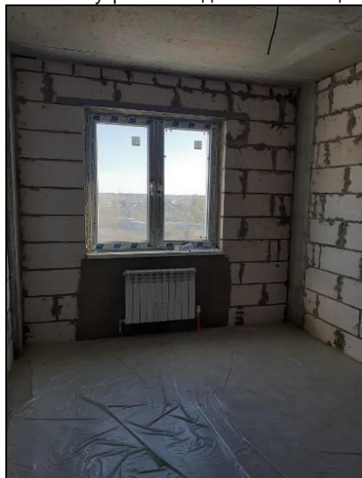
Фото 14. Внутренний вид жилых помещений
