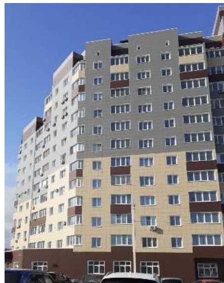
Фото. 2. Внешний вид жилого дома
