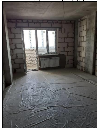
Фото 10. Внутренний вид жилых помещений
