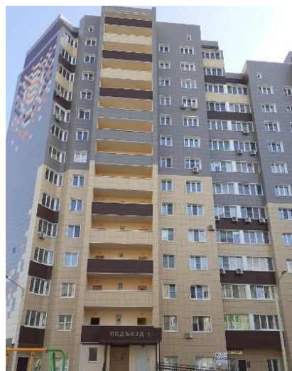
Фото. 3. Внешний вид жилого дома
