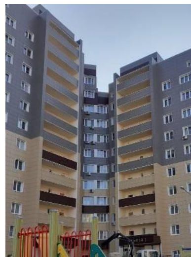
Фото. 4. Внешний вид жилого дома
