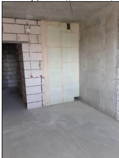
Фото 16. Внутренний вид жилых помещений
