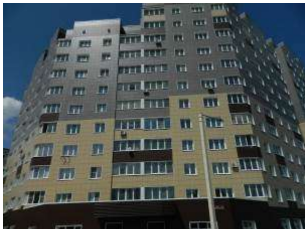
Фото. 1. Внешний вид жилого дома
