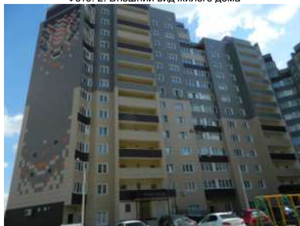
Фото. 4. Внешний вид жилого дома
