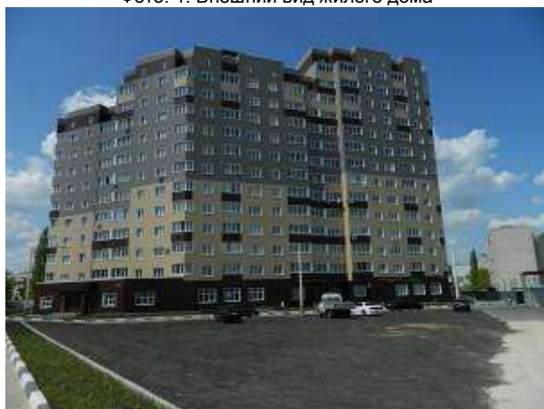
Фото. 3. Внешний вид жилого дома
