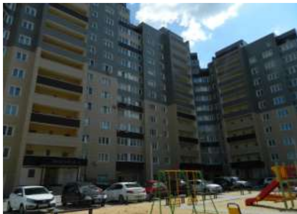
Фото. 6. Внешний вид жилого дома
