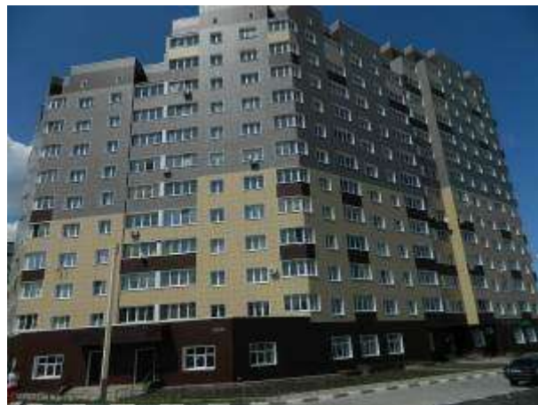
Фото. 2. Внешний вид жилого дома
