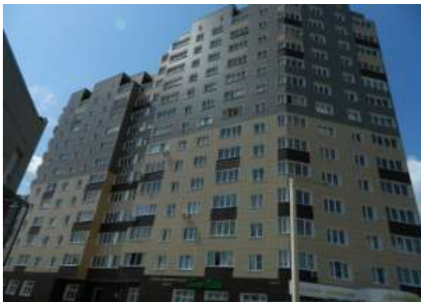
Фото. 5. Внешний вид жилого дома
