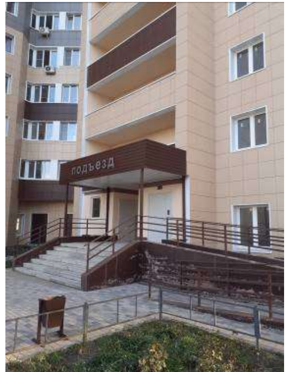
Фото. 6. Внешний вид жилого дома
