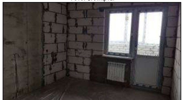
Фото 10. Внутренний вид жилых помещений
