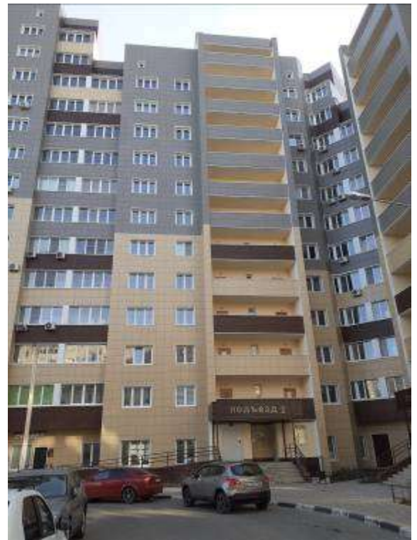
Фото. 4. Внешний вид жилого дома
