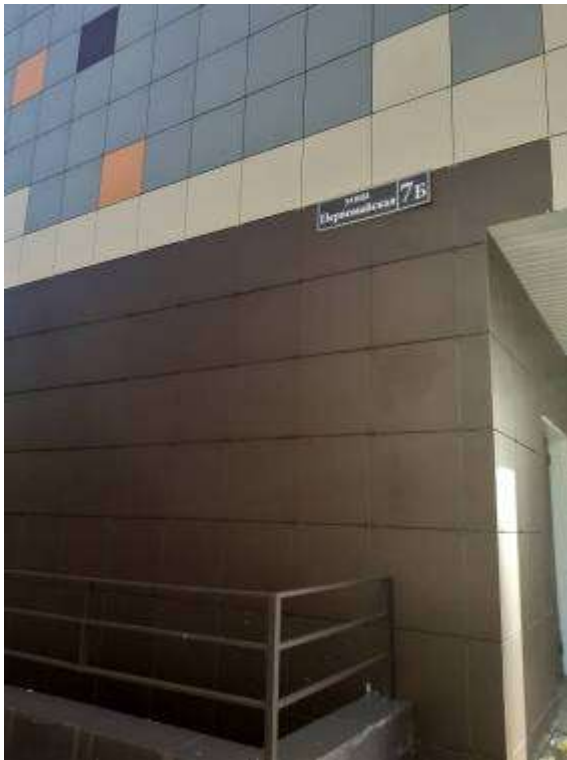
Фото. 5. Внешний вид жилого дома
