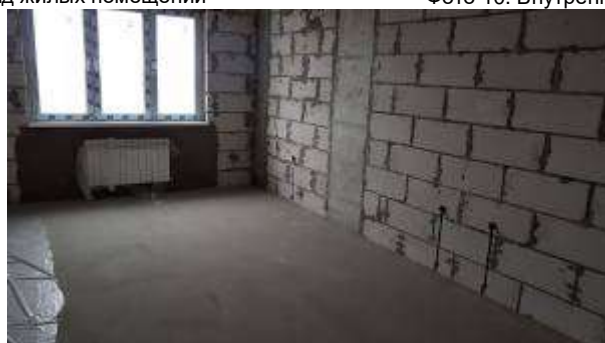
Фото 11. Внутренний вид жилых помещений
