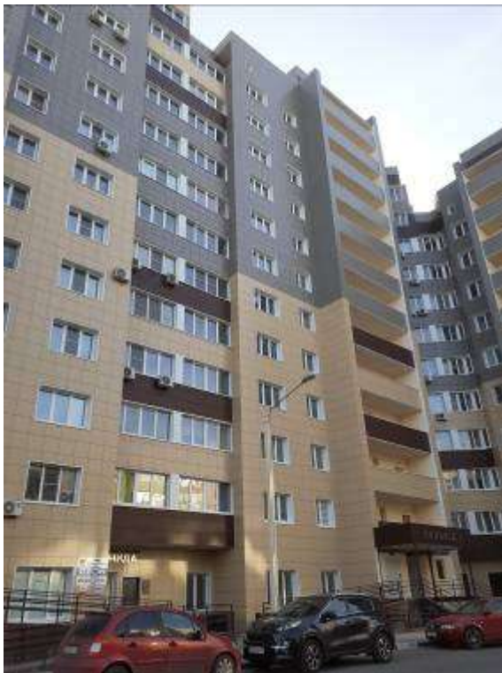
Фото. 3. Внешний вид жилого дома
