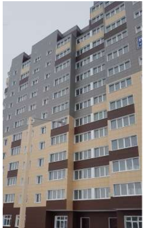
Фото. 2. Внешний вид жилого дома
