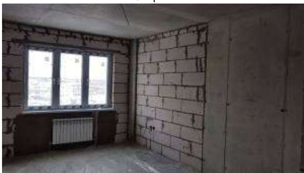
Фото 9. Внутренний вид жилых помещений
