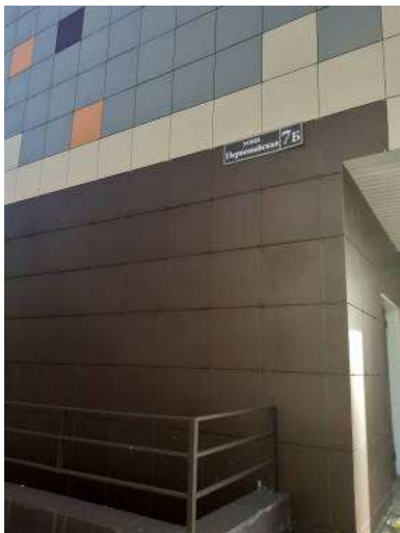
Фото. 5. Внешний вид жилого дома
