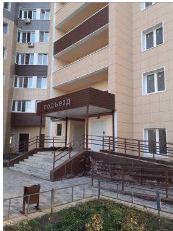
Фото. 6. Внешний вид жилого дома
