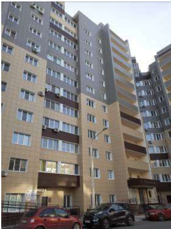
Фото. 3. Внешний вид жилого дома
