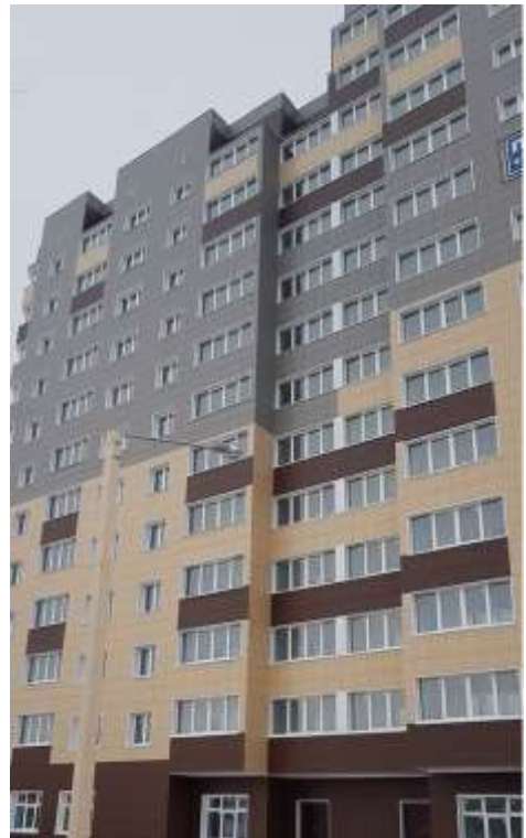
Фото. 2. Внешний вид жилого дома
