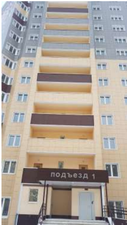
Фото. 1. Внешний вид жилого дома
