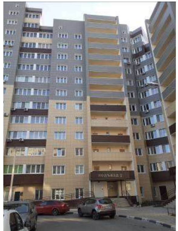
Фото. 4. Внешний вид жилого дома
