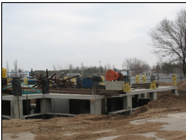
Фото 3. Внешний вид дома
