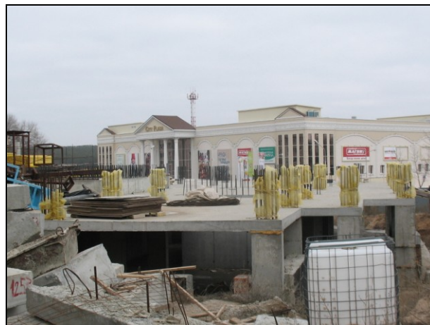
Фото 4. Внешний вид дома
