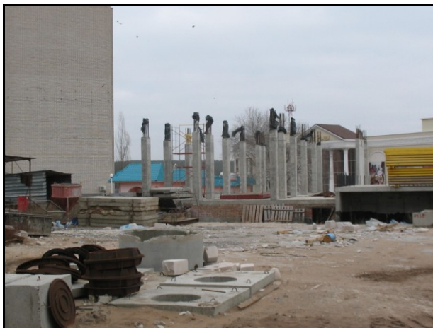
Фото 1. Внешний вид дома
