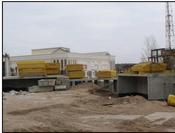
Фото 2. Внешний вид дома
