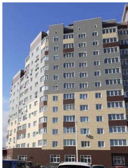
Фото. 2. Внешний вид жилого дома
