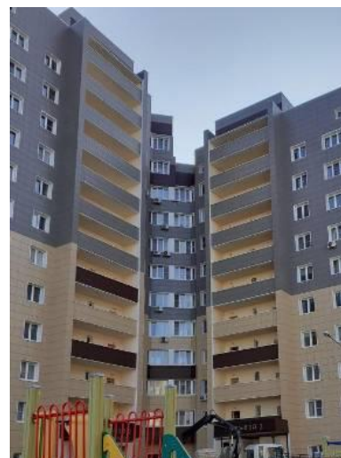
Фото. 4. Внешний вид жилого дома
