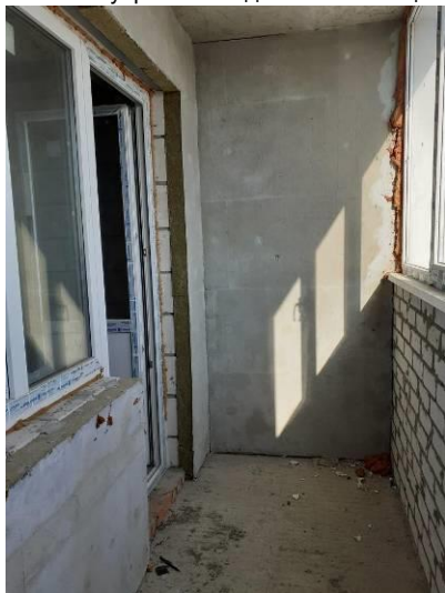
Фото 13. Внутренний вид жилых помещений
