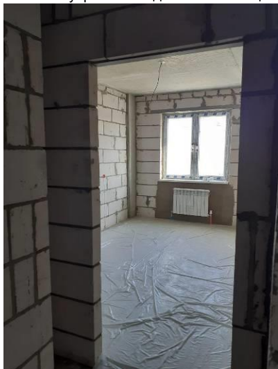
Фото 15. Внутренний вид жилых помещений
