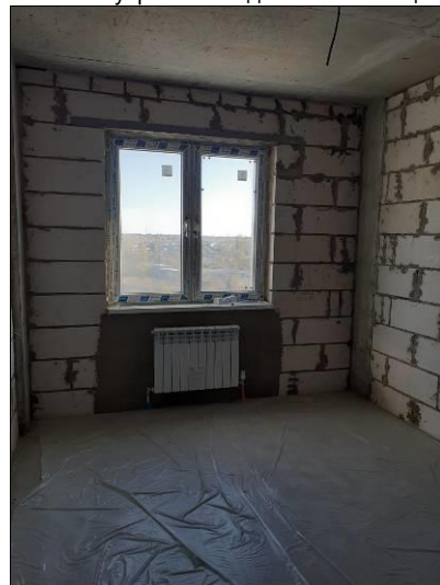
Фото 14. Внутренний вид жилых помещений
