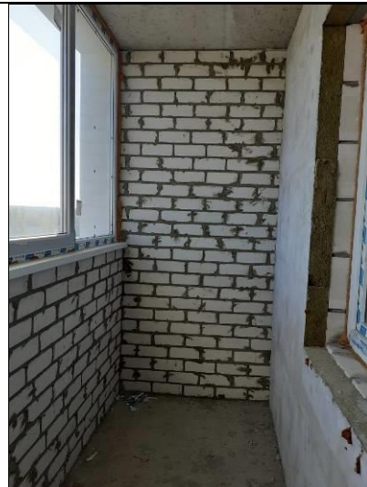
Фото 12. Внутренний вид жилых помещений
