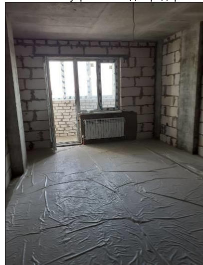
Фото 10. Внутренний вид жилых помещений
