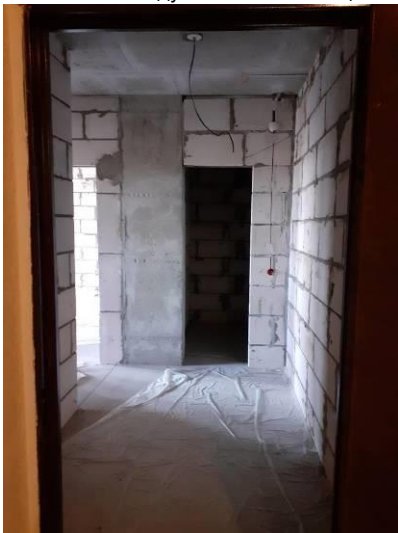
Фото 9. Внутренний вид жилых помещений
