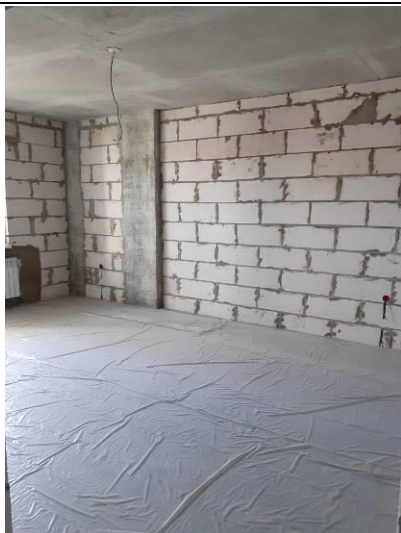
Фото 11. Внутренний вид жилых помещений
