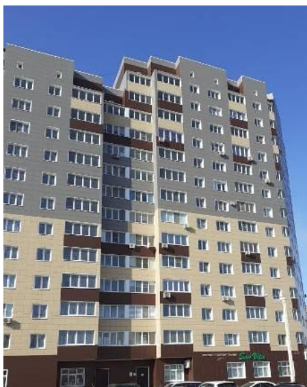
Фото. 1. Внешний вид жилого дома
