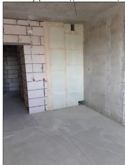
Фото 16. Внутренний вид жилых помещений
