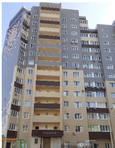
Фото. 3. Внешний вид жилого дома
