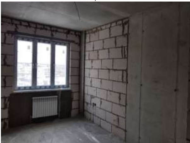
Фото 5. Вид внутри квартир
