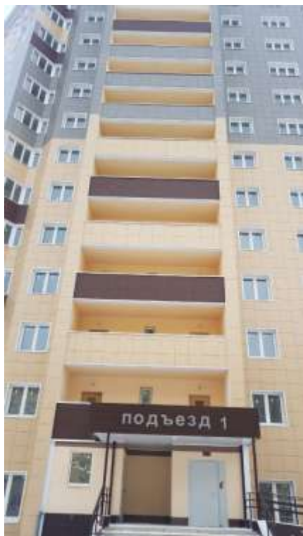
Фото. 1. Внешний вид жилого дома
