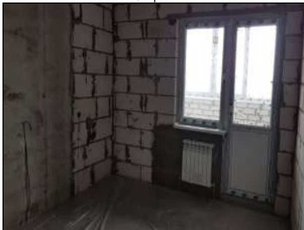
Фото 6. Вид внутри квартир
