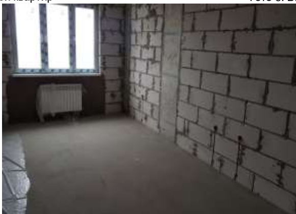
Фото 7. Вид внутри квартир
