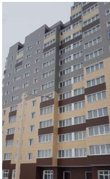
Фото. 2. Внешний вид жилого дома
