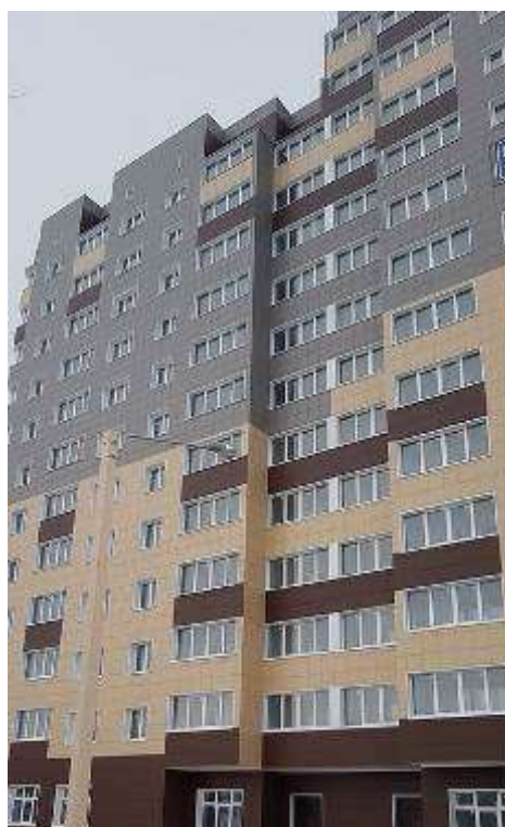
Фото. 2. Внешний вид жилого дома
