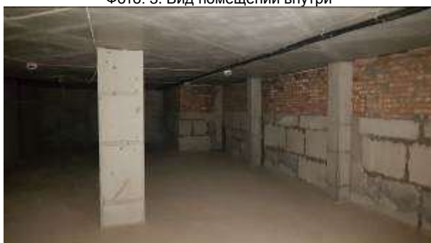
Фото. 5. Вид помещений внутри
