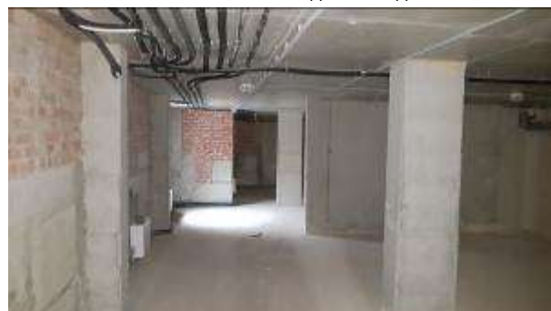
Фото. 4. Вид помещений внутри
