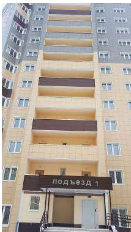
Фото. 1. Внешний вид жилого дома
