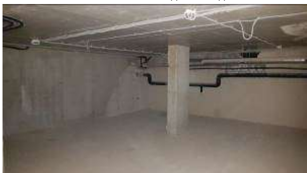
Фото. 3. Вид помещений внутри
