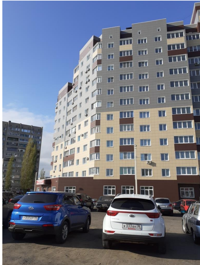
Фото 2. Общий вид дома
