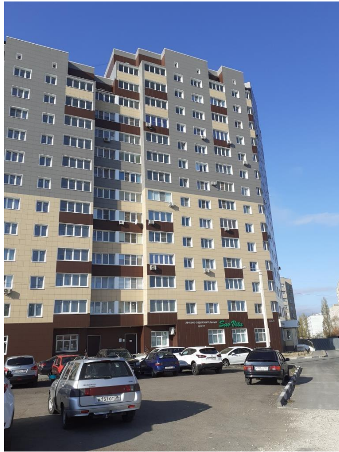
Фото 1. Общий вид дома
