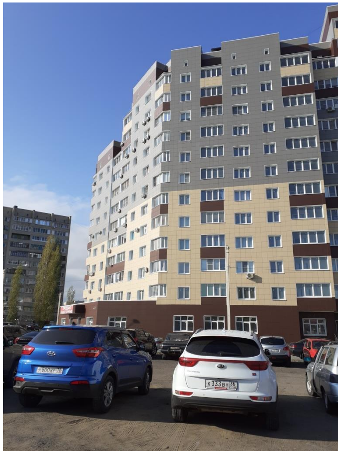
Фото 2. Общий вид дома
