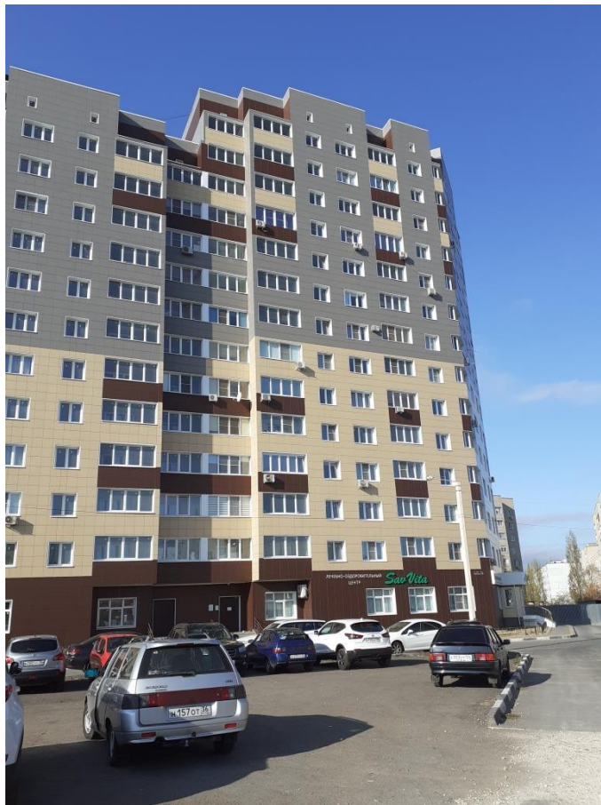
Фото 1. Общий вид дома
