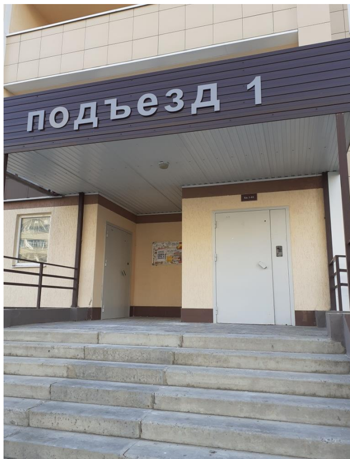
Фото 3. Вход в подъезд
